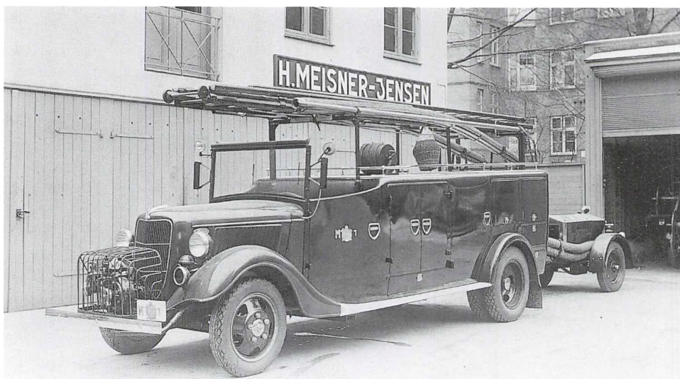
Lynby-Taarbæk Brandvæsens Ford V8-brandsprøjte af Normaltype II ved leveringen i 1937. Karrosseriet var opbygget af firmaet H. Meisner-Jensen, og vognen var forsynet med en 1000 liter/min. Aster III vandpumpe og en 1500 liter/min. skumpumpe. Desuden havde vognen en vandtank på 400 liter og en skumvasketank på 100 liter.
