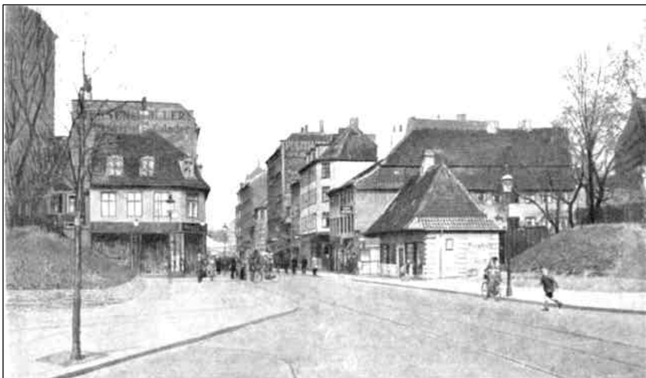
Torvegade set fra Ravelinen i 1925 inden vejreguleringen.
