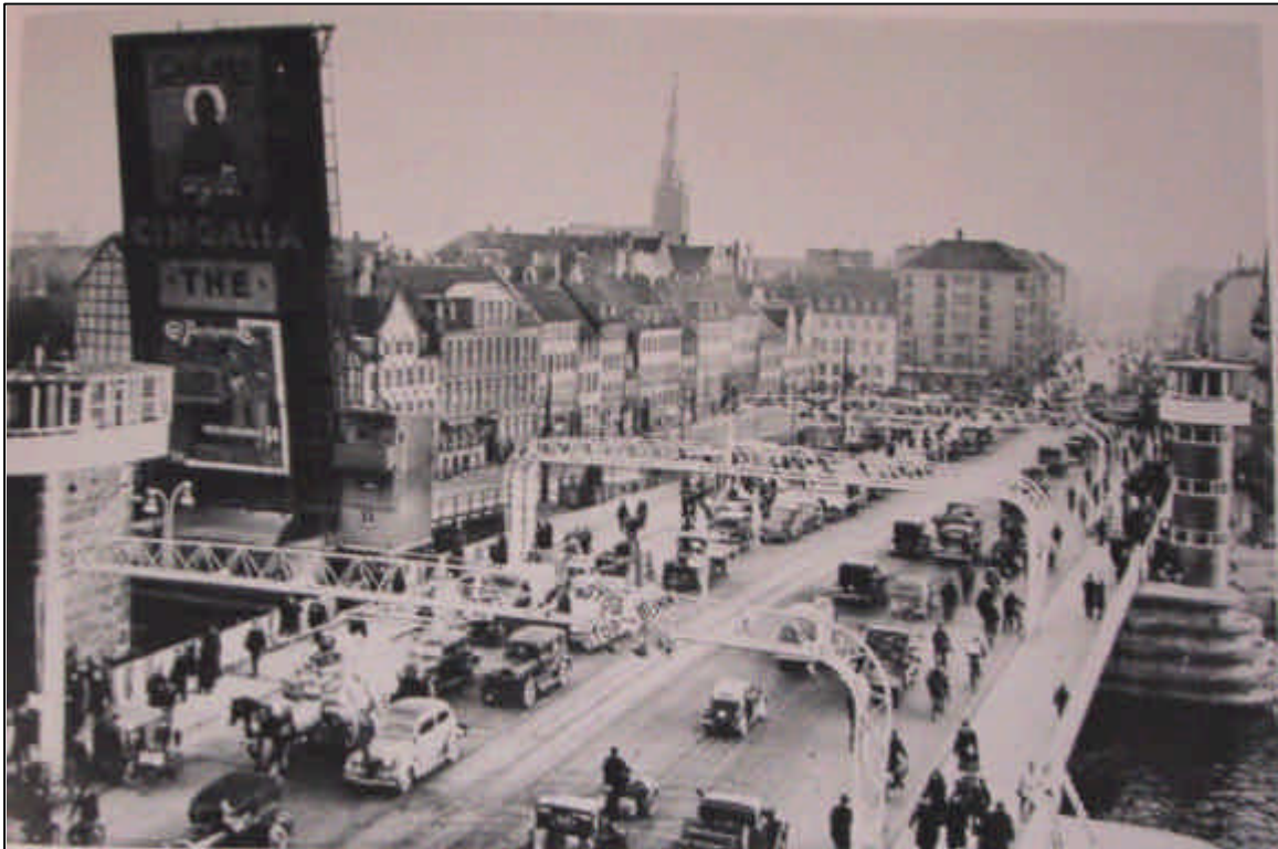
1934 og 1938. Den midlertidige bro sammen med den gamle 1908-bro og sammen med den nye 1937 B&W-bro.
