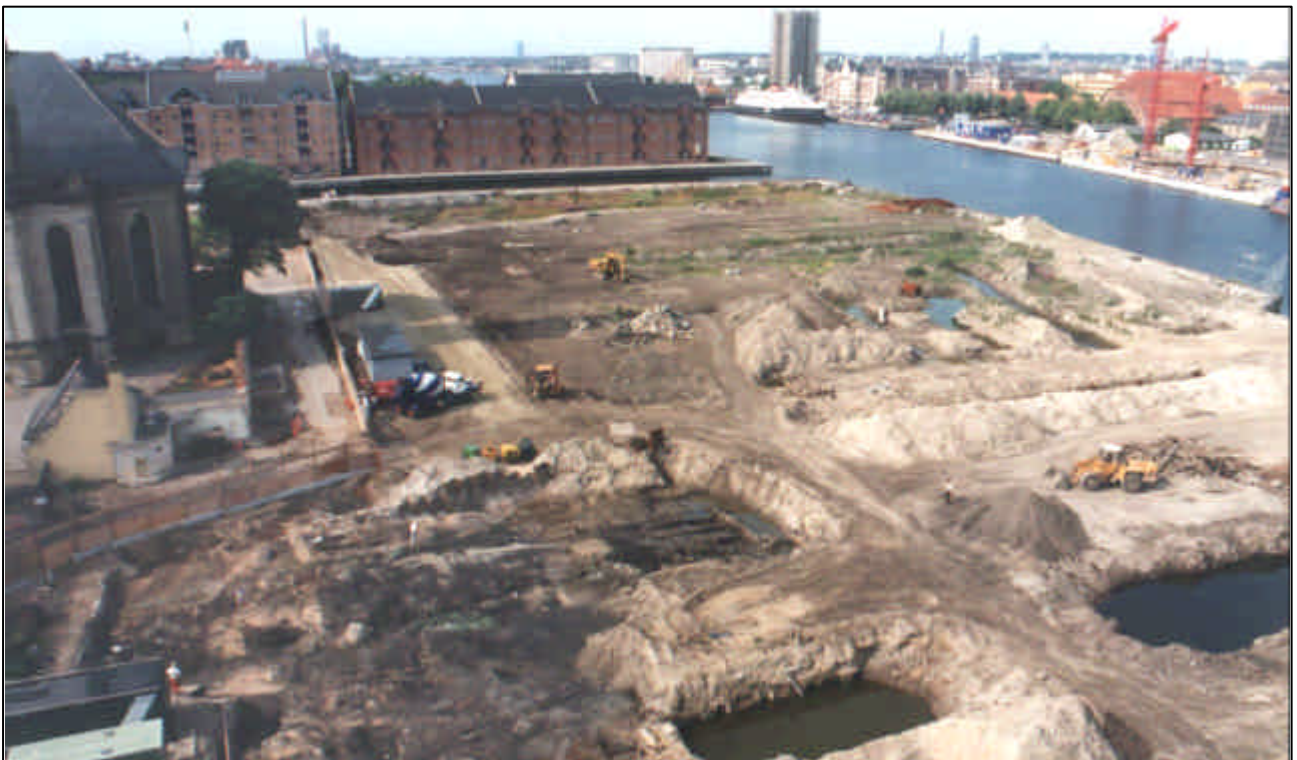
Christiansbro 9. august 1996. Byplanen for området, der er fra 1995, er baseret på de historiske retningslinier fra 1617!
